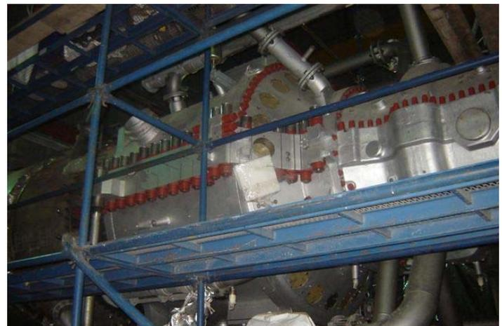
Fig 7. AE64.3A+ GAS TURBINE INSTALLED IN VLORE SITE
